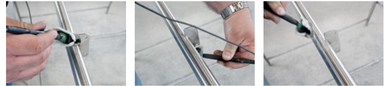
Entfernen der Verfärbungen, die durch das Schweißen entstanden sind
