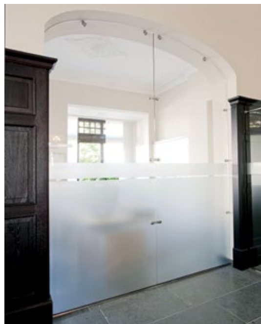
Raumtrennung mit Festelementen zu den Büros
